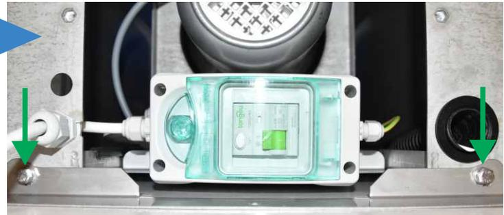
5. Отметьте отверстия в держателе с помощью маркера на стене в том же положении, где были болты (**красная стрелка**). Снимите центрифугу со стены. Просверлите последнее отмеченное отверстие, вставьте дюбель, снова установите центрифугу на настенный держатель, надавите на крышку центрифуги сверху, и прикрутите защитную пластину к стене с помощью шурупа из нержавеющей стали (**зеленая стрелка**).
