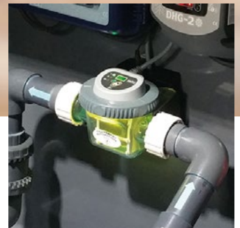
Встановлення хлоратора Installation of the chlorinator
